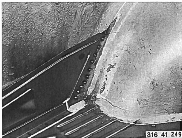
Las de scheidingswand aan de linker- en rechterzijde aan de wielkuip (CO 2 -lasapparaat).
